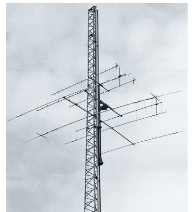
HF帯 V-UHF八木アンテナの据付例
