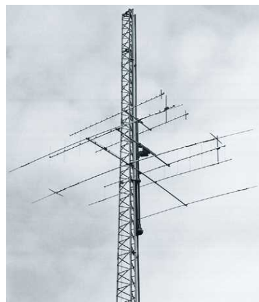
HF帯 V・UHF八木アンテナの据付例
