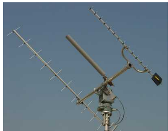
ビームアンテナの据付例
